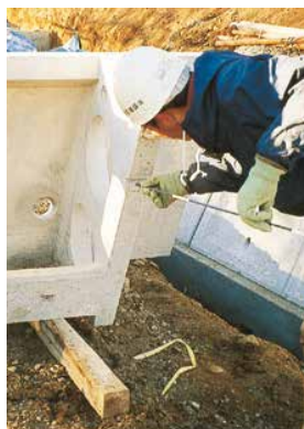
1 セパレーターの取付け
