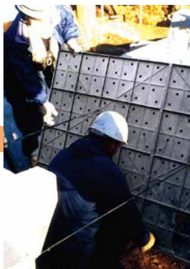
2 KCパネルの取付け
