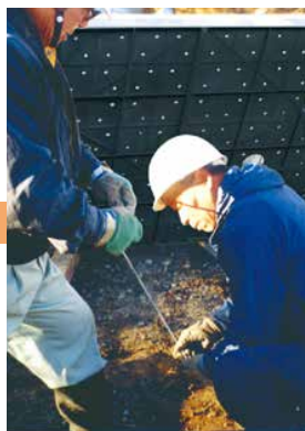
3 KCパネル固定 ナットの取付け
