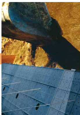
6 裏込材料の投入
