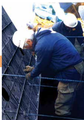
5 KCパネルの固定
