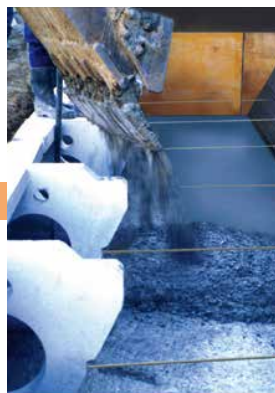
7 胴込・裏込コンクリートの打設
