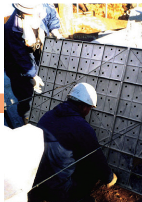
2 KCパネルの取付け
