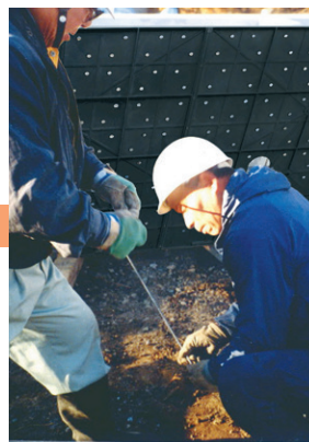
3 KCパネル固定 ナットの取付け
