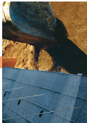
6 裏込材料の投入
