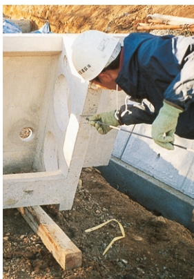
1 セパレーターの取付け
