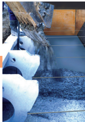
7 胴込・裏込コンクリートの打設
