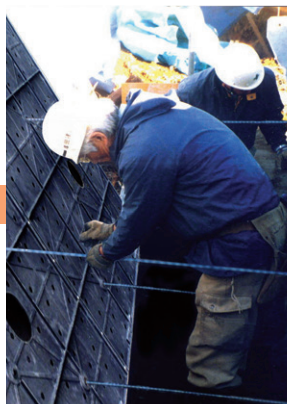
5 KCパネルの固定
