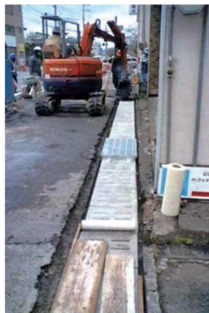
▼繊維ネット敷設
