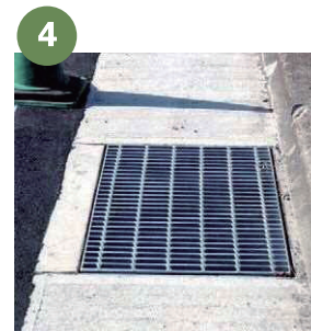
グレーチング設置
