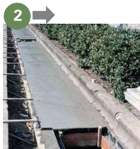
コンクリート打設
