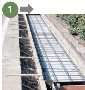
KCフォームの上に配筋した状態
