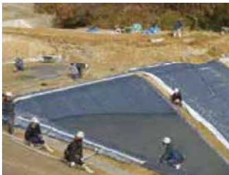
モルタル注入
