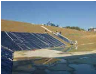
ファイブリフォームマット敷設
