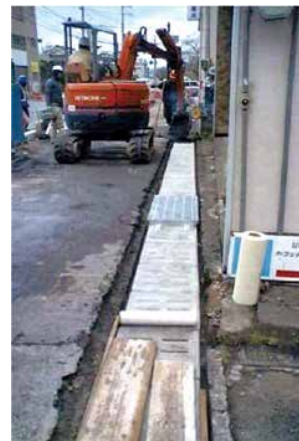
▼繊維ネット敷設
