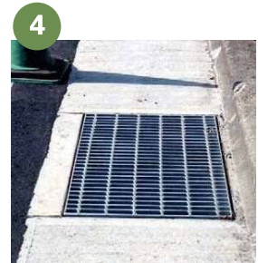
グレーチング設置
