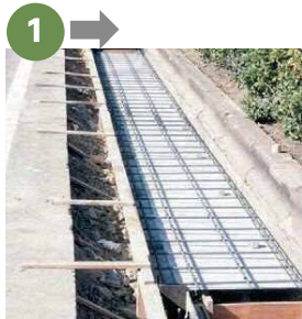
KCフォームの上に配筋した状態
