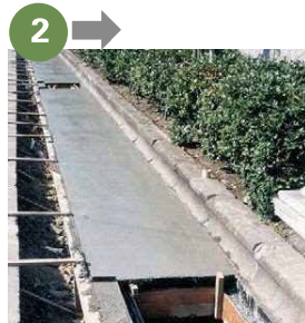
コンクリート打設
