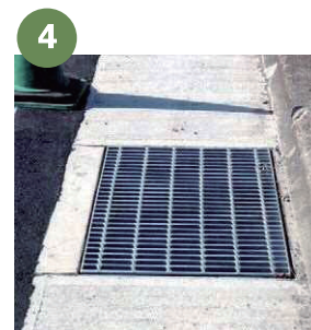
グレーチング設置
