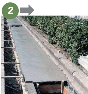
コンクリート打設
