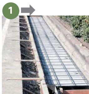
KCフォームの上に配筋した状態
