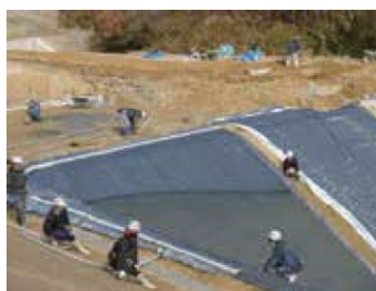
■モルタル注入
