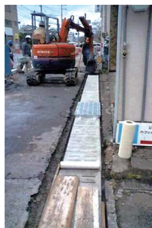
▼繊維ネット敷設
