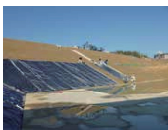
■ファブリフォームマット敷設
