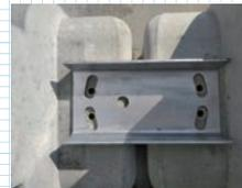
※2 接続金具 200×80 HDZ55 M20 ボルトにて固定する。
