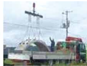
アーチリング吊上
