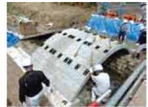
アーチリング据付
