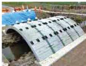
アーチリング施工完了
