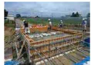
バックフィルコンクリート打込
