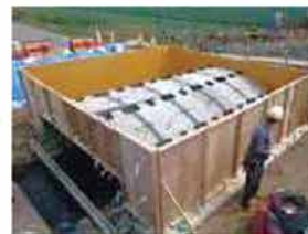
バックフィル用型枠組立完了
