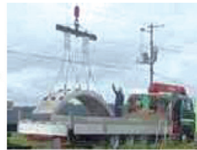
アーチリング吊上
