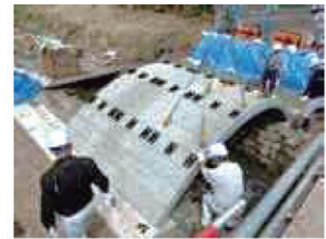
アーチリング据付
