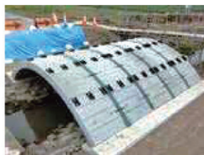
アーチリング施工完了
