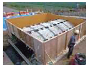
バックフィル用型枠組立完了
