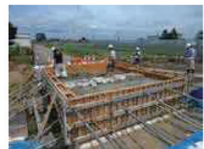
バックフィルコンクリート打込
