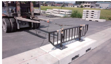
耐荷重試験状況
