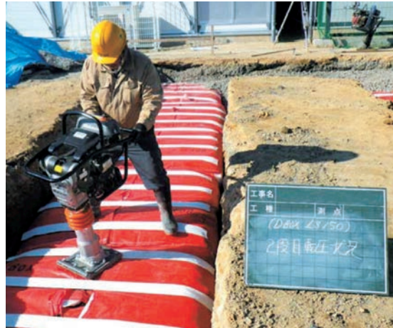
4) 締固め機械で転圧
