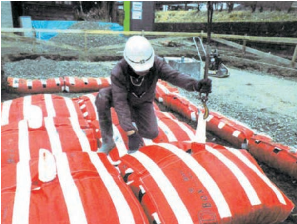
3) 重機やクレーンで吊り上げ 敷設箇所に設置
