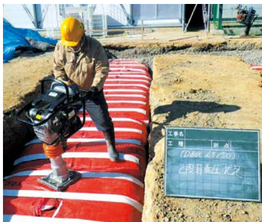
4) 締固め機械で転圧
