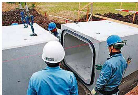
ジョイントシール材そう入状況
