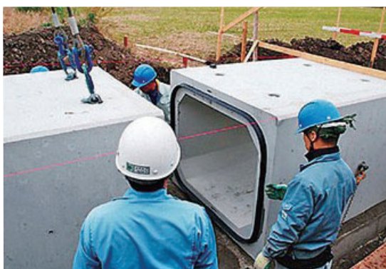
ジョイントシール材そう入状況
