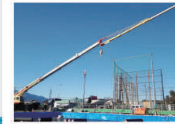
クレーン重機（現場支給）
