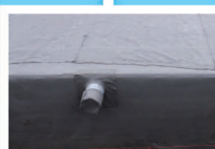
8 流入口 / 管口取付け状況
