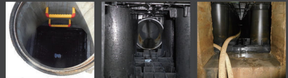
▲ ハイドロスタッフ上部の点検人孔部 ▲ ハイドロスタッフ上段の流入管部 ▲ ハイドロスタッフ下段の流出口部
