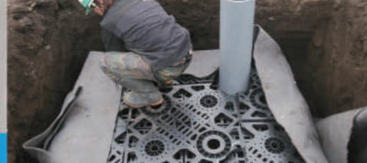
▲ 宅地造成/各戸分散方式、ガレージ下設置
