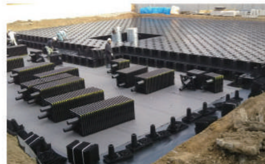
▲ スポーツ施設/テニスコート下設置
