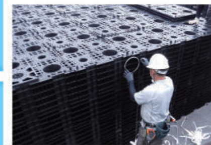
7 流入(流出)口 / 管口加工 (現場支給)
