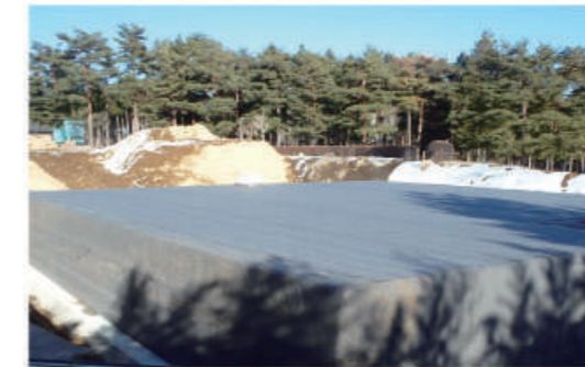
▲ ゴルフ場/芝散水用貯水槽
