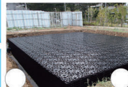
6 ユニット組立 / 完了・出来高確認
