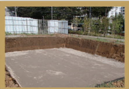
1 掘削 / 基礎工事
