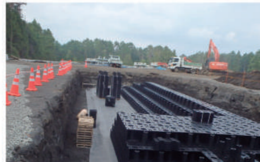
▲ 工場施設/大型トラック搬入路下設置
