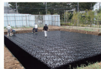
5 ユニット組立 / 天板敷設
