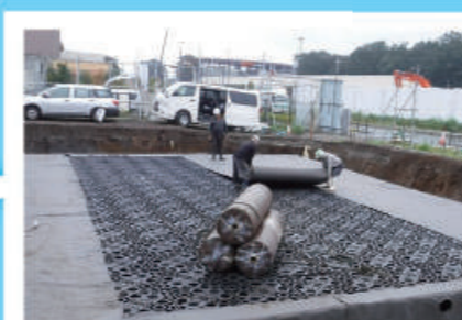
9 上部透水シート 敷設
