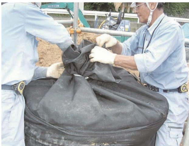
③充填が完了したら投入口縛り紐で投入口を縛ります。
