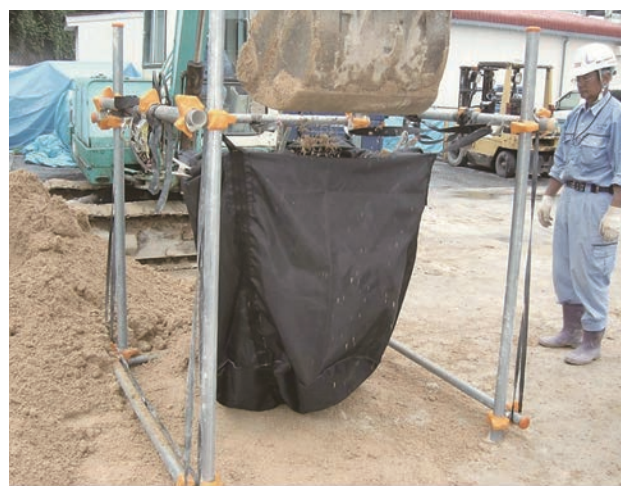
②TKバックの変形や損傷に注意しながら土砂を充填します。
