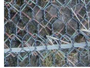
錆びた落石防止金網を撤去せず、STKネットで更新
