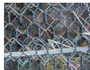
錆びた落石防止金網を撤去せず、STKネットで更新
