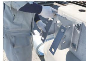
付属のボルト2本でブラケットをベースプレートに取り付ける
