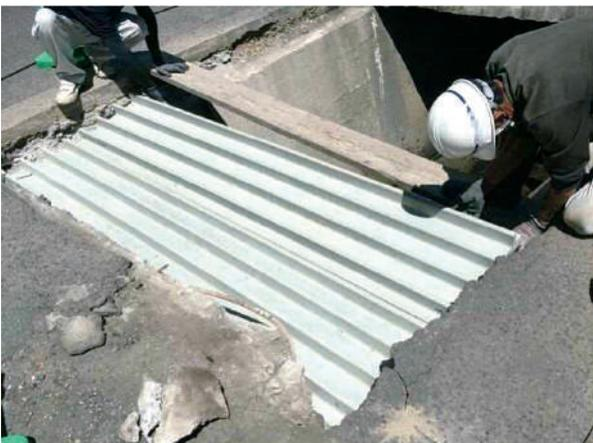
※コンクリート打設時の側圧でたわまないように製品にはキャンバー(緊張力による反り)がついていますが、コンクリートの打設後はフラットになります。
