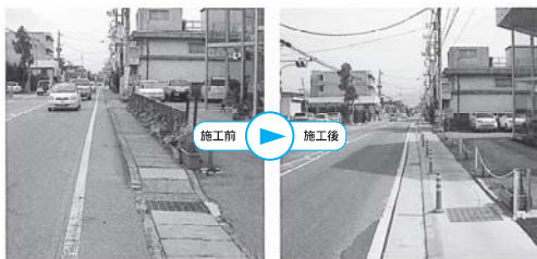
側溝蓋周辺歩道部も改修した例
