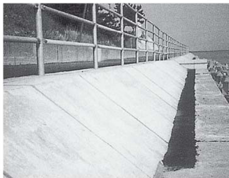
秋田県 船川港湾事務所 港湾局部改修工事
