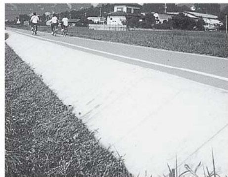
茨城県 下館土木事務所 5国補自転車道第102-3,103-3合併工事
