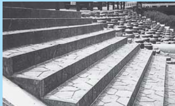
福岡県 田川土木事務所 臨時河道整備工事
