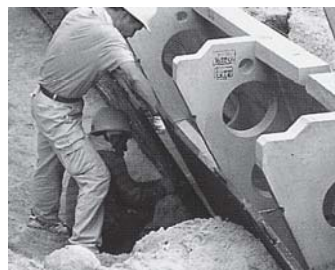
2 KCパネルの固定
