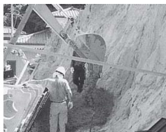
3 裏込材料の投入
