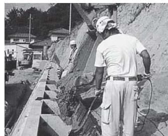
4 胴込コンクリートの打設
