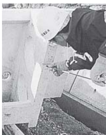
1 セパレータの取付け
