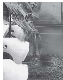
7 胴込・裏込コンクリートの打設
