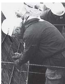
5 KCパネルの固定
