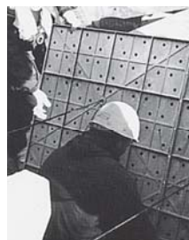
2 KCパネルの取付け
