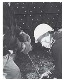
3 KCパネル固定ナットの取付け
