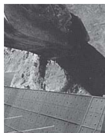
6 裏込材料の投入
