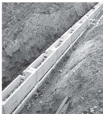
2 魚巣ブロック据付
